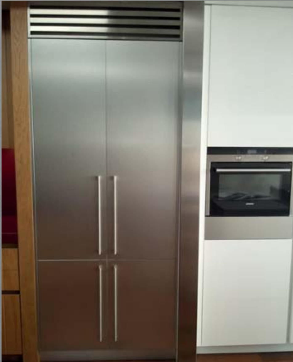
Instalación rejilla de ventilación
